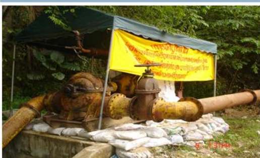
จุดที่1 ติดตั้งเครื่องสูบน้ำบริเวณหลังถ้ำตลอด
