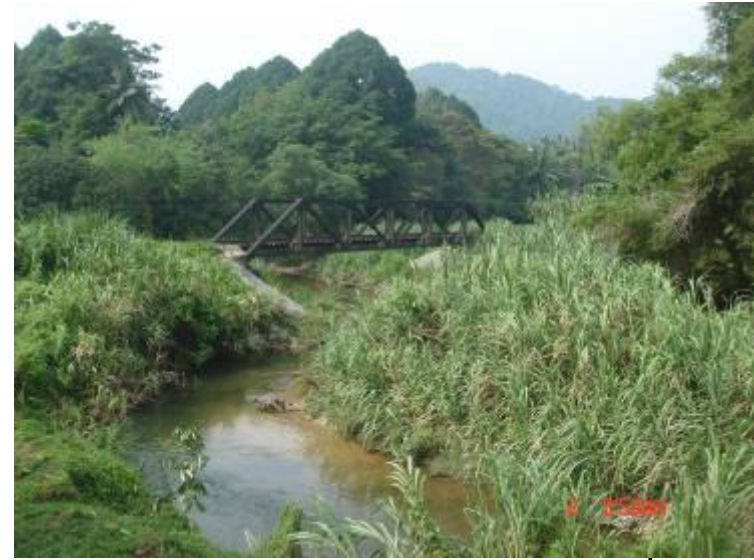
ทางรถไฟสายใต้สร้างสมัยรัชกาลที่ 5 สร้างสะพานไว้หลายแห่ง
