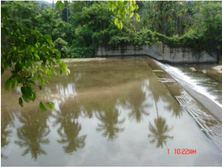
คลองท่าเลา การตกตะกอนหน้า สันฝาย ร้อยละ 90
