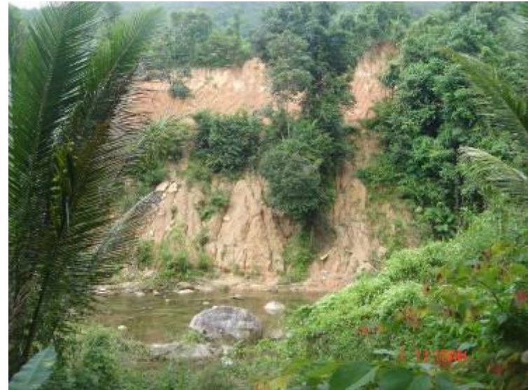
การตัดถนน ทำให้เกิดการกัดเซาะ พังทลายหน้าดิน
